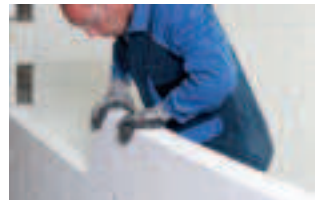
Plaats de steen in de lijmlaag binnen de 9 min.
