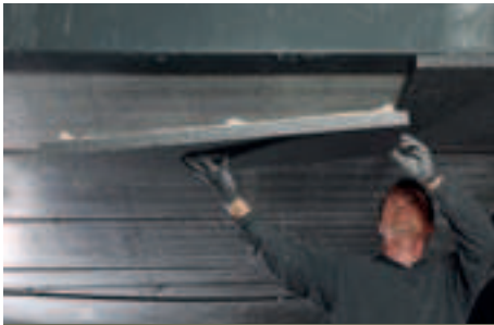
Na ca. 5 min plaat aanbrengen.
