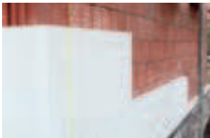
Buitengevelisolatie met afwerkingspleister
