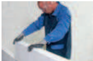
Plaats de volgende steen er tegen
