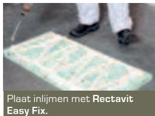
Min. 5min wachten tot lijm voldoende kleeftkracht heeft.
