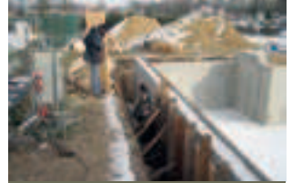
Platen op zijn plaats brengen.
