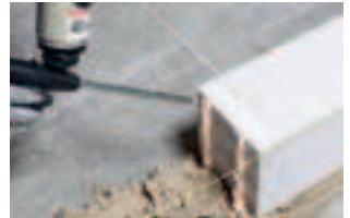
Kimblokken mogen verticaal opgevoegd worden
