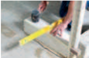
Eerste blok waterpas plaatsen
