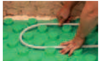
Na 1u kan het buizensysteem reeds aangebracht worden.
