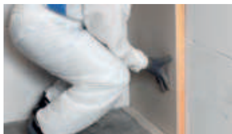
Plaat goed positioneren
