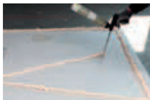
1. Plaat inlijmen met zigzag vormen
