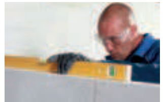
Controleer de pasheid na elke laag
