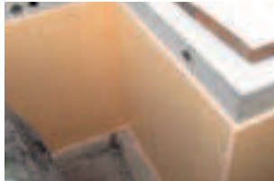
Aansluitingen hoeken afwerken.
