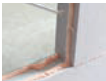
Verlijmen van cellenbeton
