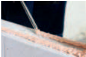
Breng 2 evenwijdige lijms- strengen Rectavit Easy Fix aan
