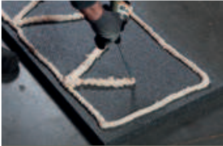
Isolatieplaat inlijmen.
