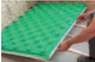
Plaat aanbrengen in de lijm-laag.
