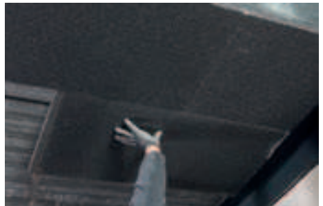
De volgende plaat kan er onmiddellijk naast geplaatst worden.
