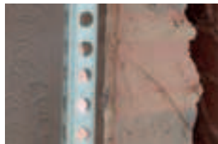
Bevestiging van pleisterprofielen
