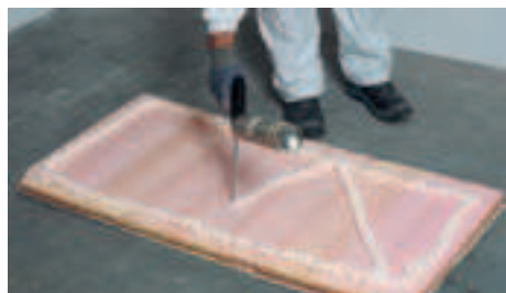
Rectavit Easy Fix op de plaat aanbrengen. Creëren van gesloten compartimenten.
