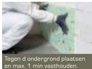
Min. 5min wachten tot lijm voldoende kleeftkracht heeft.
