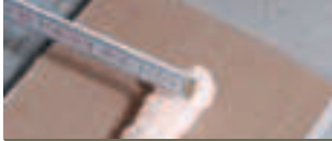
Ø 1 à 2 cm, vlak-op-vlak verlijming
