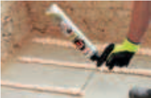
Rectavit Easy Fix aanbrengen op ondergrond.
