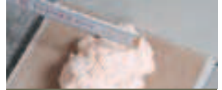
Ø min. 5 cm, max 2 cm oneffenheid uitvlakken
